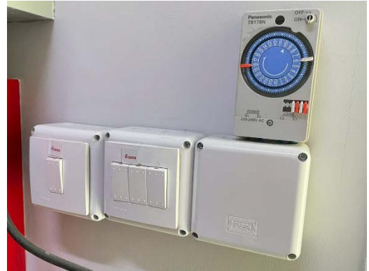
ภาพที่ 2-21 ระบบเปิด-ปิดไฟ ด้วยการตั้งเวลา
