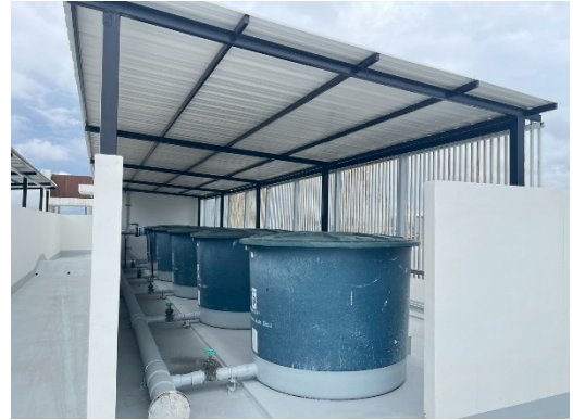
ถังสำรองชั้นดาดฟ้า (อาคาร B)
