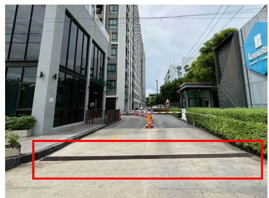
ภาพที่ 2-39 ตะแกรงครอบรางระบายน้ำ
