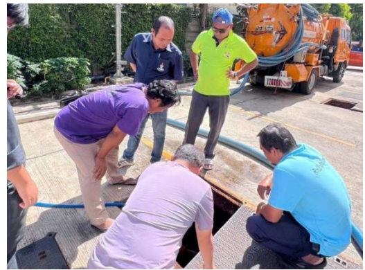
ภาพที่ 2-6 การสูบตะกอนระบบบำบัดน้ำเสีย
