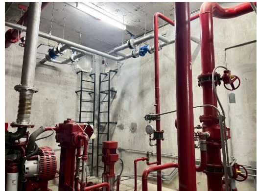
เครื่องสูบน้ำแบบเครื่องยนต์และเครื่องสูบน้ำดับเพลิง ภาพที่ 2-25 ระบบป้องกันอัคคีภัย (ต่อ)
