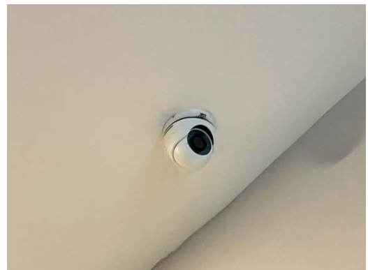
ภาพที่ 2-37 ระบบกล้องโทรทัศน์วงจรปิด (CCTV)
