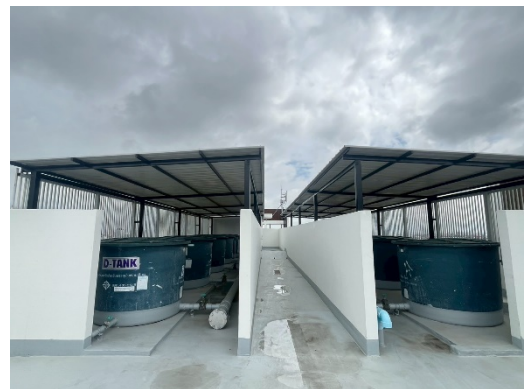
ถังสำรองชั้นดาดฟ้า (อาคาร A)
