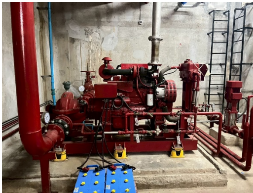
เครื่องสูบน้ำแบบเครื่องยนต์และเครื่องสูบน้ำดับเพลิง ภาพที่ 2-25 ระบบป้องกันอัคคีภัย (ต่อ)
