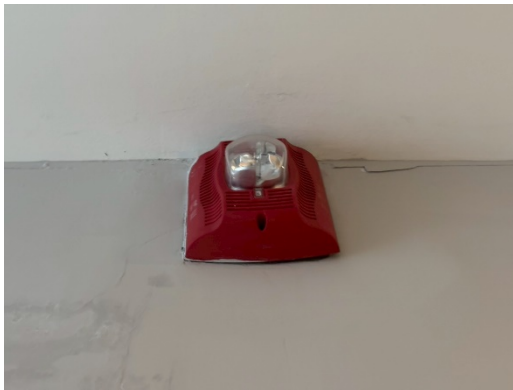
อุปกรณ์ส่งเสียงสัญญาณแจ้งเหตุ
