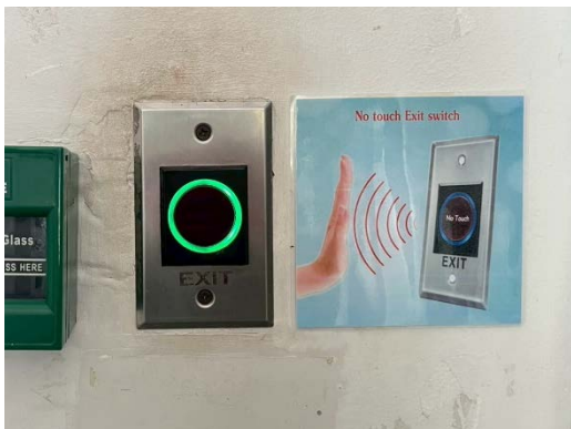
ภาพที่ 2-36 ระบบควบคุมเข้า-ออกอาคาร
