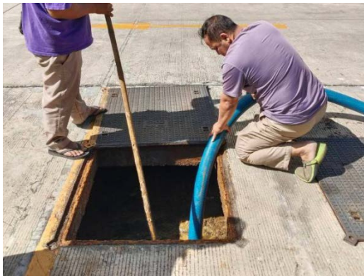
ภาพที่ 2-6 การสูบตะกอนระบบบำบัดน้ำเสีย
