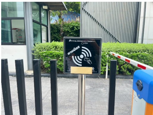
ภาพที่ 2-30 เครื่องตรวจจับ Key Card
