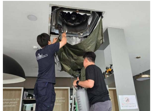
ภาพที่ 2-24 การล้างเครื่องปรับอากาศส่วนกลาง
