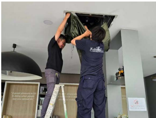
ภาพที่ 2-24 การล้างเครื่องปรับอากาศส่วนกลาง
