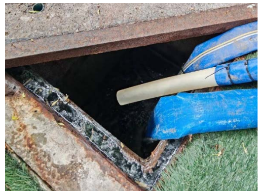
ภาพที่ 2-10 ตะแกรงดักขยะบริเวณบ่อพักน้ำสุดท้าย
